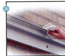
Entfetten Sie das Mauerprofil an der Oberkante der Mauer.
