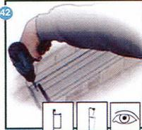
Schrauben Sie das Aussenteil auf dem Mauerprofil fest.
