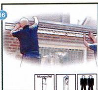
Halten Sie das Wandprofil gegen die Wand, damit die Befestigungslöcher in die Wand gebohrt werden können (2 Personen). Halten Sie das Wandprofil im Blei und zeichnen Sie dieses auf die Wand.
